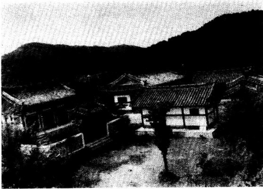
錦山書院全景 梧峯公(諱之悌)晦屏(諱體仁)配亨
